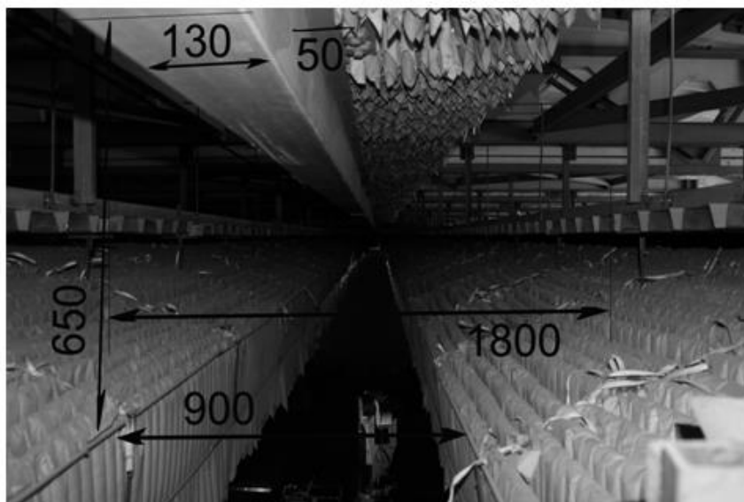
Рисунок 1 – Геометрия монорельса тельфера с размерами проема под него
